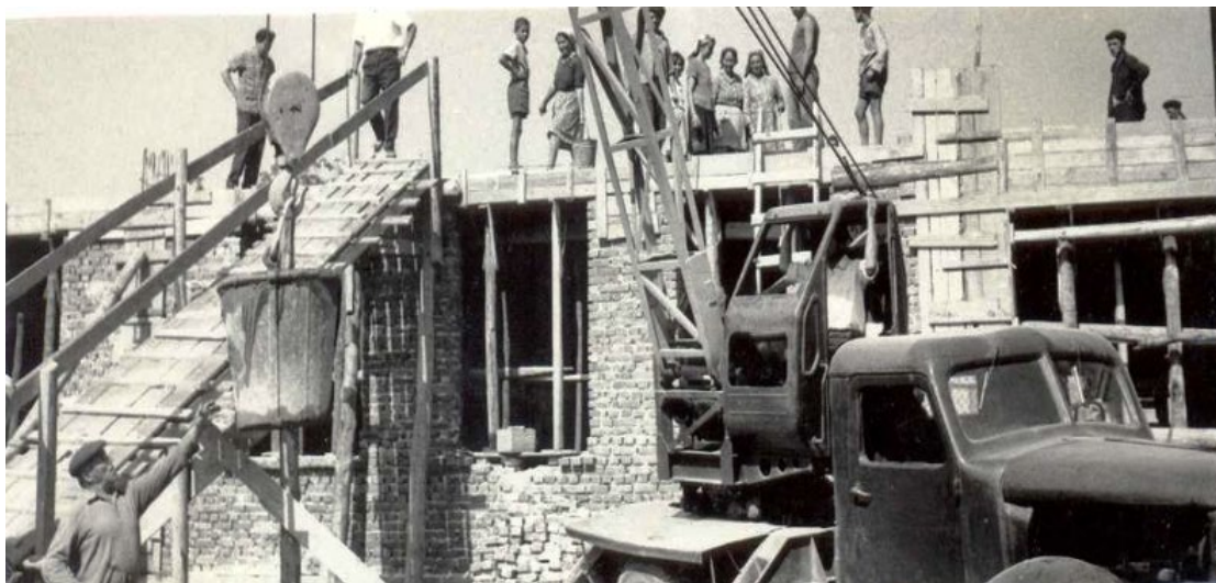
Imagini de la construirea Școlii nr 1 Șotânga
