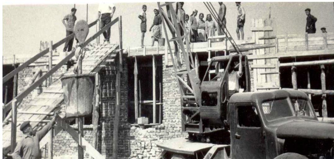
Imagini de la construirea Școlii nr 1 Șotânga
